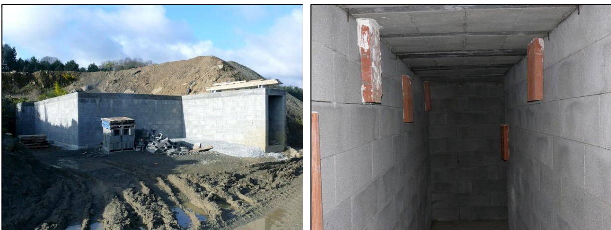
Tunnel avant d'être enfoui sous le remblais de terre (à gauche) et briques plâtrières installées dans le tunnel
